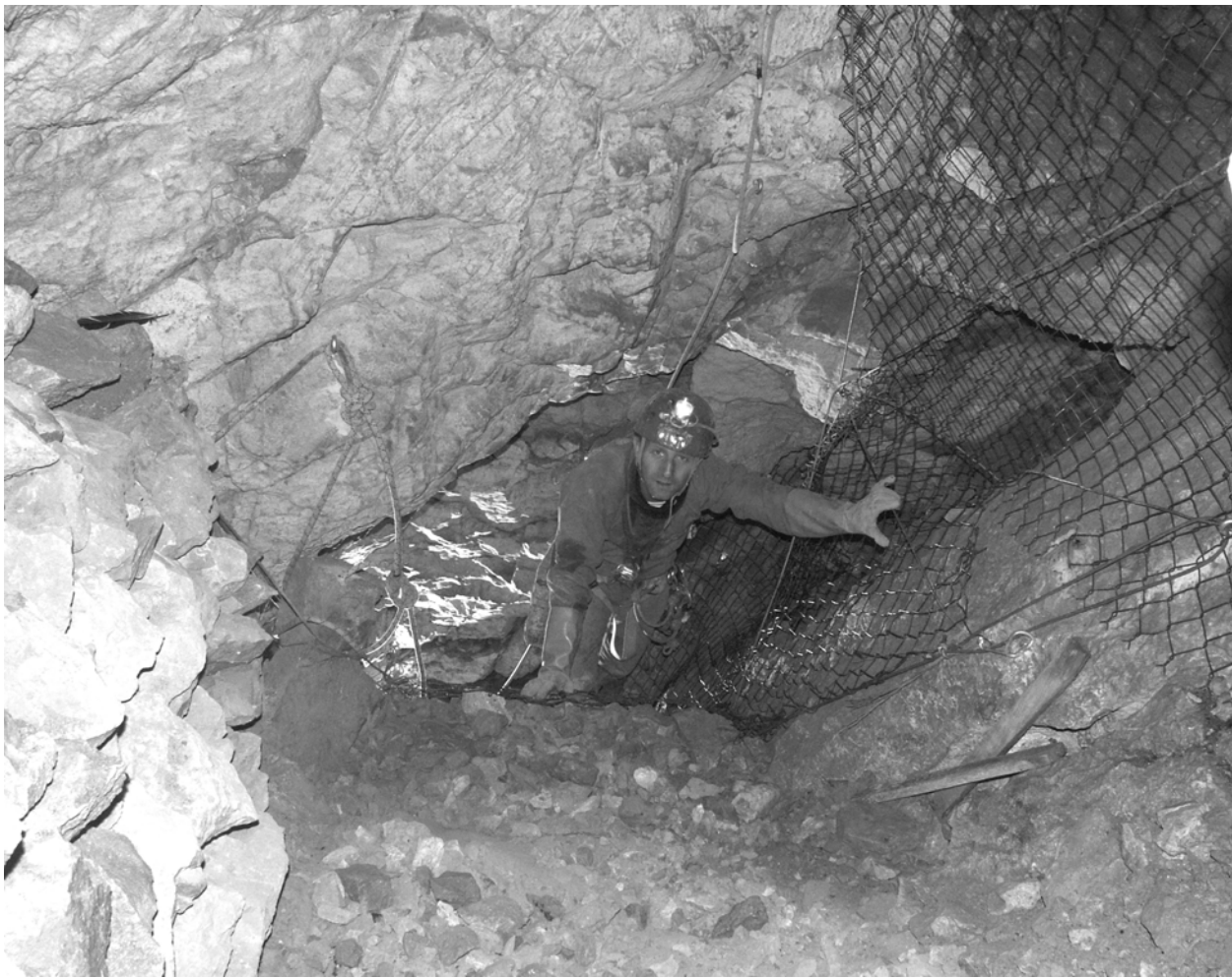
MS 14 : le sommet de la trémie à -33 m. Un conduit vertical de 7 m a été creusé entre la paroi et l'éboulis. Ce dernier est retenu par des câbles et du grillage sur toute sa hauteur. De la mousse expansée donne une « certaine » cohésion à l'édifice.
